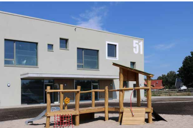
Neubau der Kita Hannah Arendt
